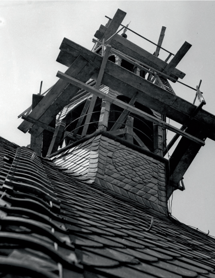
Der eingerüstete Dachreiter-Turm auf dem Dach der Marienkirche im Sommer 1961.
